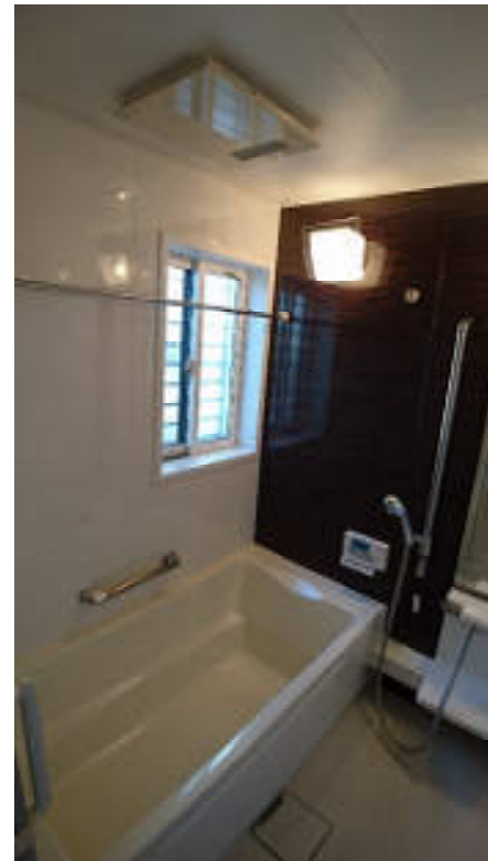
一坪タイプのシステムバス。浴室乾燥暖房機で、冬の入浴でも快適です。雨の日の洗濯物乾燥もできるので、家事がはかどります。
