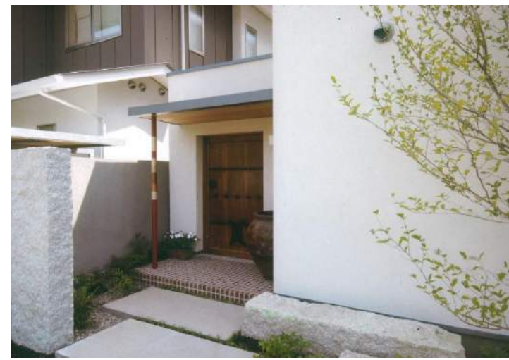
裏口には味わい深い金具を施した蔵戸を使用
